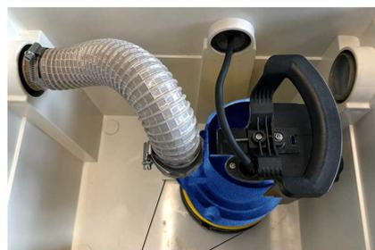
**Abb. 16:** AmaDrainer 301 / AmaDrainer 301 C einbauen
